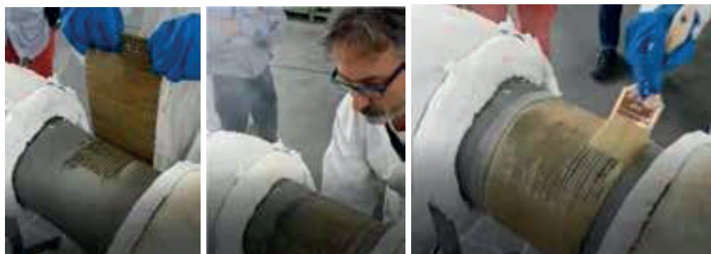
Figura 15. Varie fasi dell'esecuzione del rinforzo strutturale
