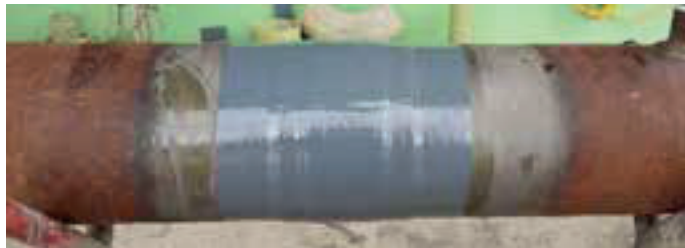
Figura 10. Completamento della riparazione mock-up
