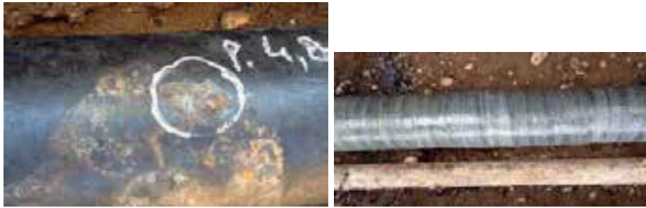
Figura 17. Esecuzione di rinforzo strutturale su tubazione ammalorata
