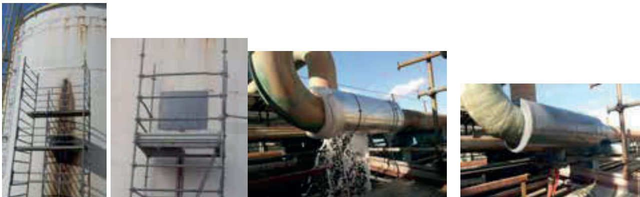
Figura 18. Esecuzione di rinforzi strutturali in presenza di perdite
