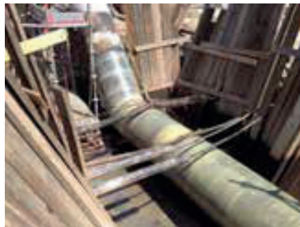
Figura 4. Rinforzo strutturale di una linea interrata
