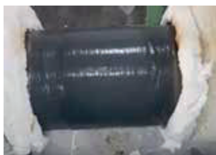
Figura 16. Completamento della riparazione
