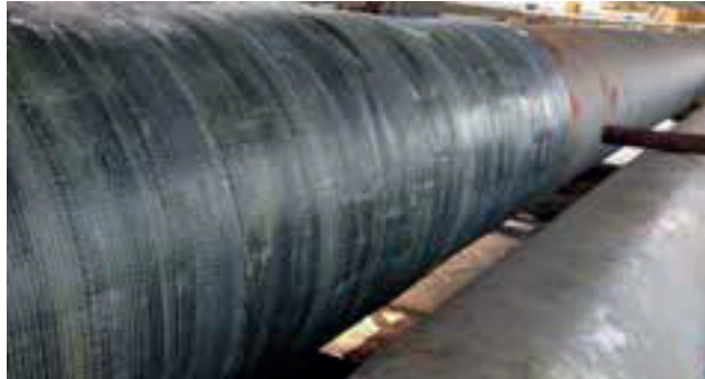
Figura 3. Rinforzo strutturale
