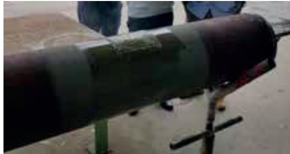
Figura 9. Esecuzione rinforzo strutturale
