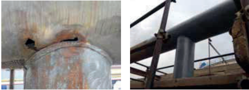
Figura 19. Intervento di rinforzo strutturale su una Tee con evidente foro
