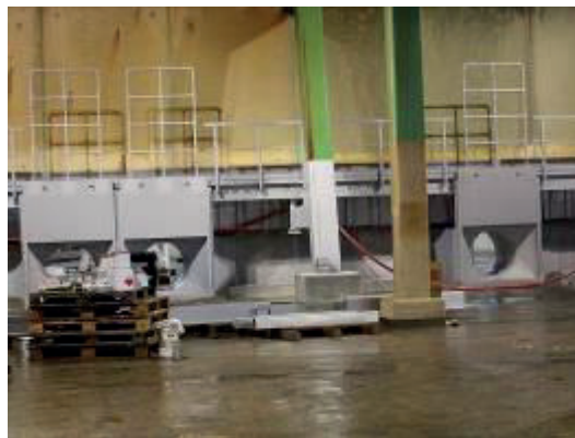
Figura 2. Strutture in materiale composito
